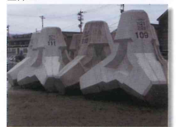
波消ブロック
