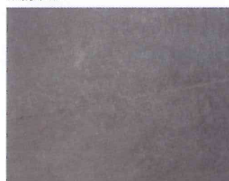
(添加コンクリート面)
