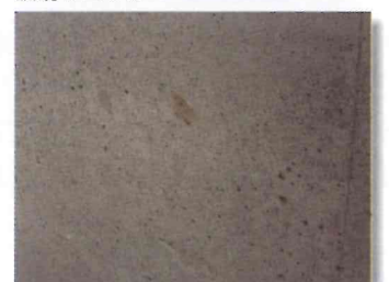
(未添加コンクリート面)
